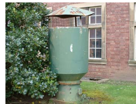
Fig. 50 Metal ventilator
